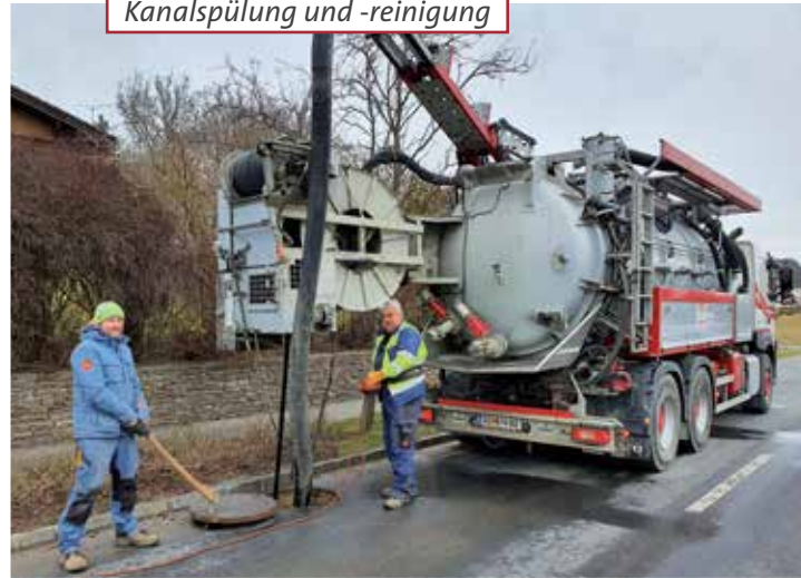
Kanalspülung und -reinigung
